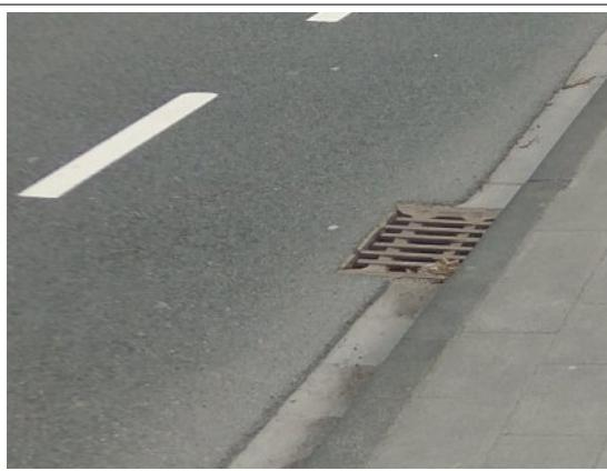
Gullydeckel im Schutzstreifen verringern den Querschnitt des Radstreifens.
